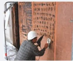
Fassadenabschirmung in Heißbitumen
